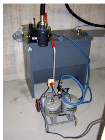
Abb. 3 Hydraulikaggregat mit angeschlossener Filteranlage während der Filtration im Nebenstrom bei normalem Aufzugsbetrieb
